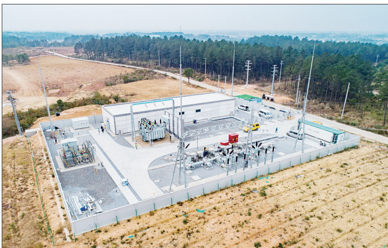
10月25日,位于怀宁县三桥镇中联村境内的模块化装配式变电站110千伏小市变电站正式投运,这是全省首个装配式2.0版智能式变电站。该站投运后,将大幅提高安庆220千伏独秀变和220千伏天柱变110千伏电压等级互供转带能力。浦劲松 陆茹 记者 雷琳琳
