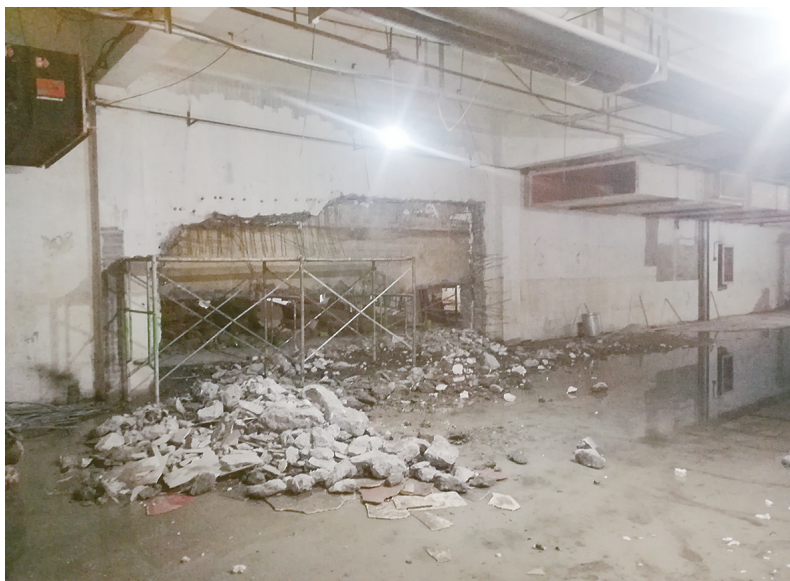
图为被拆除的人防墙
