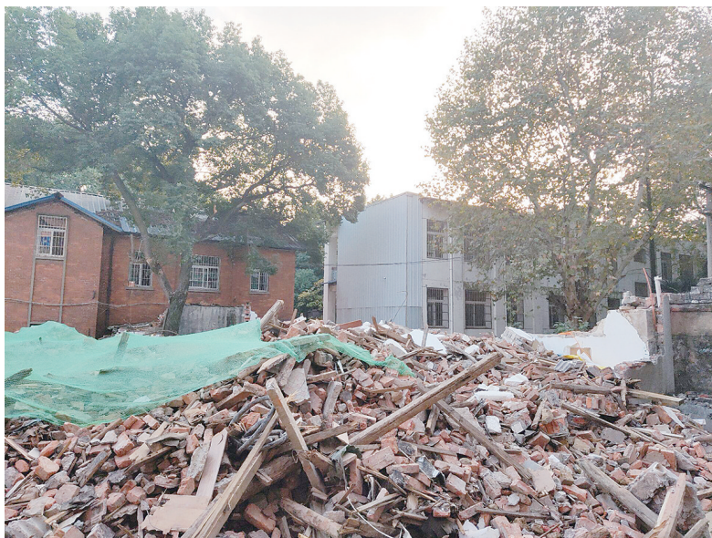
图为拆迁废墟
