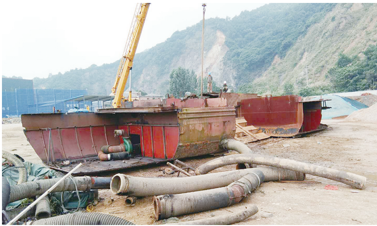
大观区河湖“四乱”整治现场,拆解船只。
