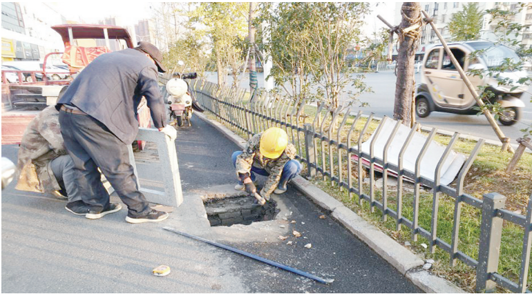
工作人员正在修复井盖
