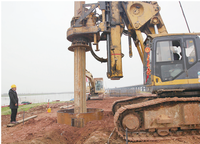
11月30日上午，石门湖航道以东段勇进路大桥桩基工程顺利开工。 徐火炬 摄
