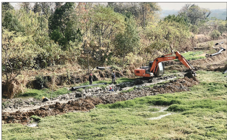
12月4日,工人在铺设污水处理厂管道。怀宁县雷埠乡始终将农村人居环境综合整治与“美丽乡村”建设同步推进,力争实现“田园美、村庄美、生活美”的美丽乡村建设目标。 檀志扬 蒋善模 摄
