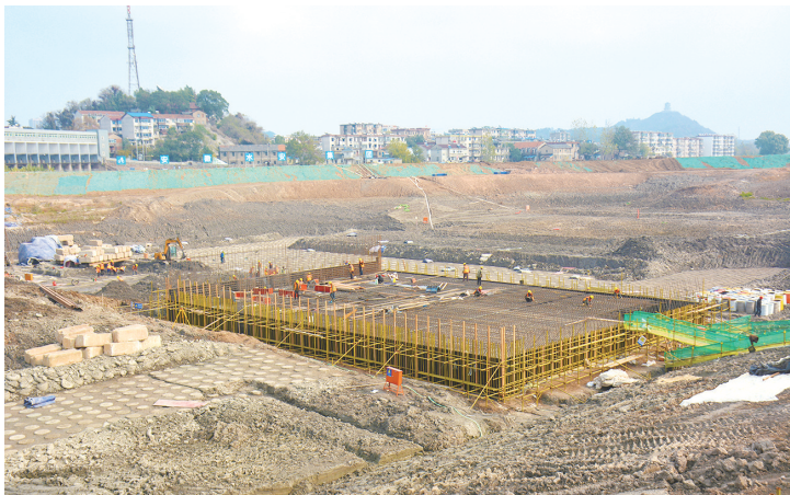
12月6日上午,在枞阳引江枢纽工程桐城市鲟鱼镇施工现场,施工人员正在进行现场作业。枞阳引江枢纽是引江济淮工程两大引江口门之一,是菜子湖线引江入口控制性枢纽工程,工程任务为引水、排洪、通航和水生态修复等。预计2022年6月底完工。
