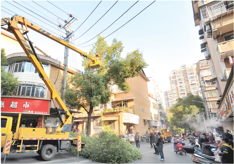
12月7日上午,迎江区双莲寺社区党委联合市城市绿化管理大队党支部开展“修剪树枝,美化家园”志愿服务活动。10余名绿化党员志愿者利用专业吊车,对健康路存在安全隐患的3棵大树进行修剪,社区党员职员志愿者在旁维持现场秩序和协助修剪工作。通过一上午的修剪清理,为居民消除了安全隐患,为社区营造了天蓝、树绿的宜居环境,此举受到广大居民一致称赞。 记者 黄有安 通讯员 江莉萍 摄
