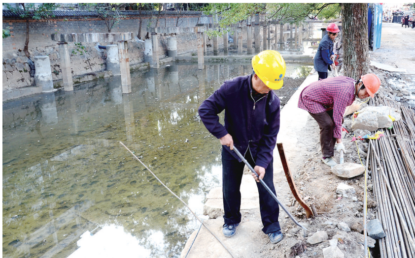
12月9日,施工人员正在修建花亭河护栏。目前,该工程河底清淤已完成,大河护栏进入刷漆收尾阶段,今年底其它附属景观工程将全面完工。
