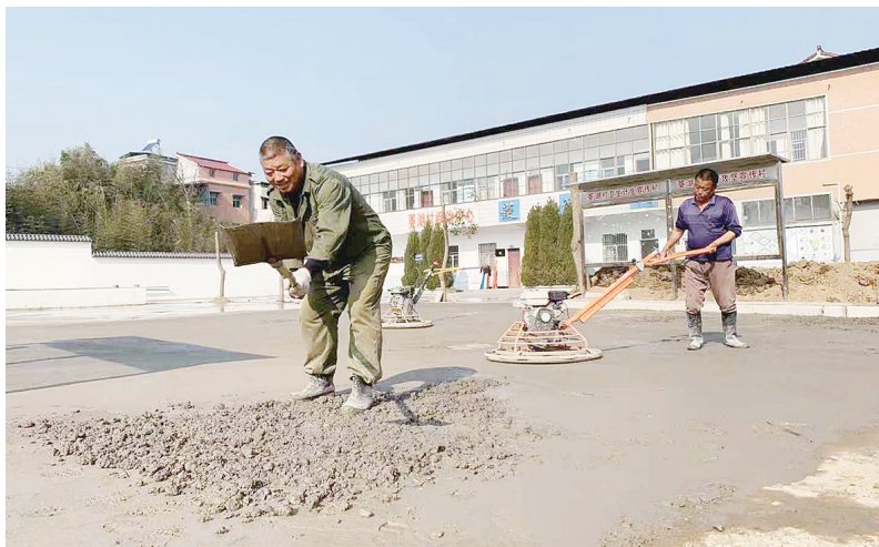
12月11日,村民文化广场正在施工。怀宁县黄龙岗镇菱湖村借助一事一议财政奖补项目20余万元资金,建设村民文化广场700平方米,更好地丰富村民文化生活。
