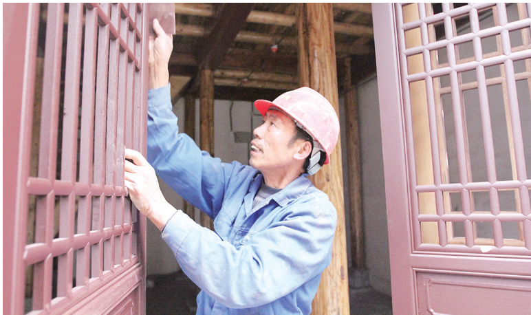
12月16日,人民路以南历史文化街区L型街区倒扒街建设现场,工人正在打磨木门。据了解,该项目已进入扫尾阶段,目前正在进行青石板道路铺设、广场、古戏台等景观建设工作,2020年元旦正式开街。 徐火炬 摄
