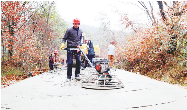
12月19日,太湖县徐桥镇南庄村,施工人员正在铺设1.8公里何冲路水泥混凝土路面,将“幸福路”修到农民的家门口。 黄有安 李艳艳 摄
