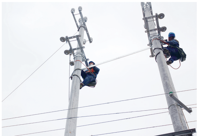
12月21日,岳西县供电公司工作人员在古坊乡安装变压器台架。
