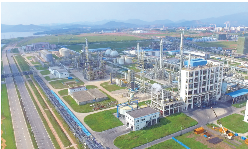
航拍曙光厂区 照片由高新区提供
