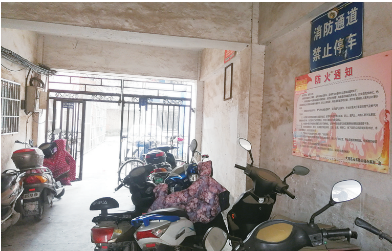
集贤花苑小区消防通道成了停车场。
