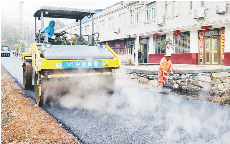
1月8日,村民在家门口铺设柏油路。怀宁县石镜乡甘露社区结合农村公路项目,发动乡贤捐资20万元修建2条总长3.1公里柏油路,既方便了群众出行,又美化了乡村环境。 檀志扬 许莹莹 摄
