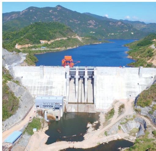
图为下浒山水库电站 邵涛 摄
