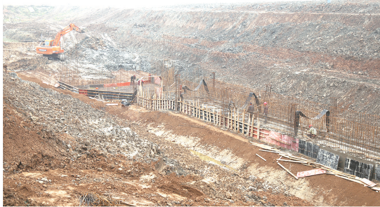
1月14日,安徽农垦华阳河农场对新建排灌两用闸站的地基进行换土回填,加固闸站基础。
