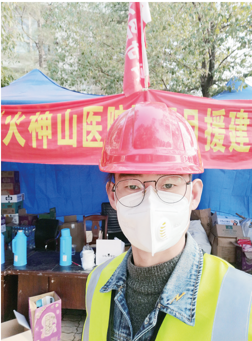
石李峰在火神山医院施工现场 石李峰提供
