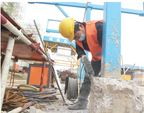
安庆机场改扩建项目现场,工人正在作业。
