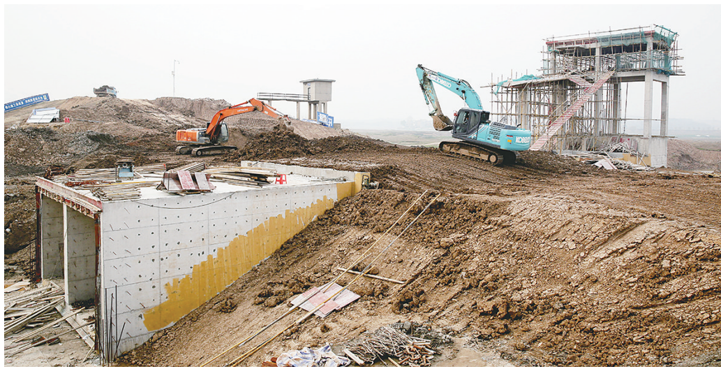
2月25日,大观区广成圩北闸工程施工现场,大型机械正在进行施工。广成圩海口镇北闸站拆除新建工程,是大观区重点水利工程项目,预计2021年4月完工。 项顺平 记者 江胜 摄
