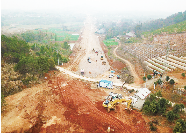
3月3日,S237怀宁段公路改建工程二期三桥至平山段项目路基工区施工现场。路欣 朱丽娜 摄
