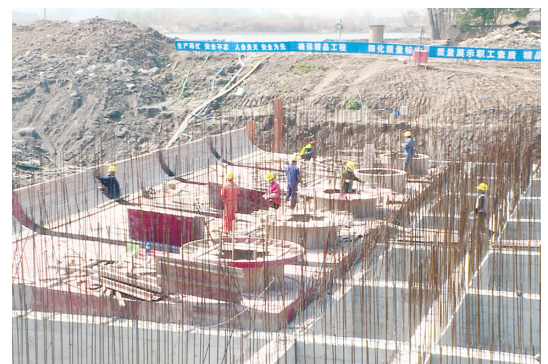
3月6日,工人正在工程施工现场施工。
