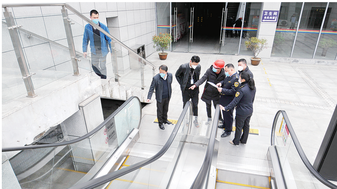
3月12日,经开区市场监管局执法人员开展特种设备专项检查。图为执法人员在安庆火车站前广场上,对6台自动扶梯进行安检,执法人员发现5台扶梯有安全隐患,当即责令关停并要求18日前必须整改到位,确保过往旅客人身安全。 记者 黄有安 通讯员 陈声友 摄
