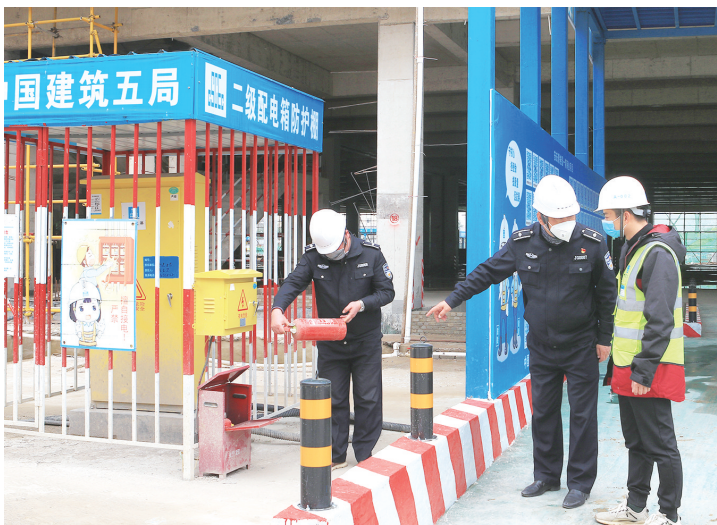
3月13日,市住建局建管处正在对中建五局承建的一项目进行疫情防控、安全生产专项检查。
