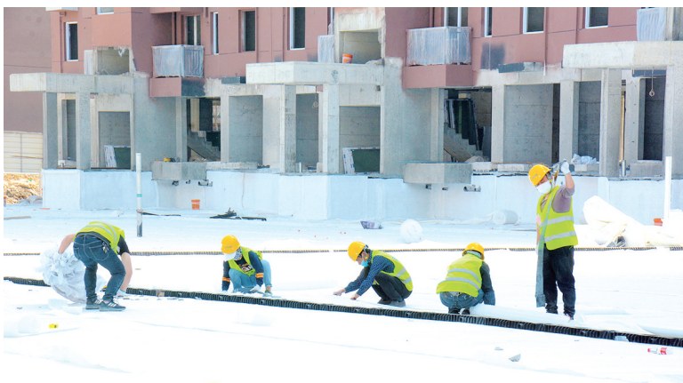
3月20日,施工人员正在铺设道排板。 路欣 摄
