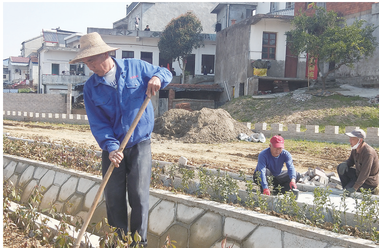
丰大村休闲广场建设现场。
