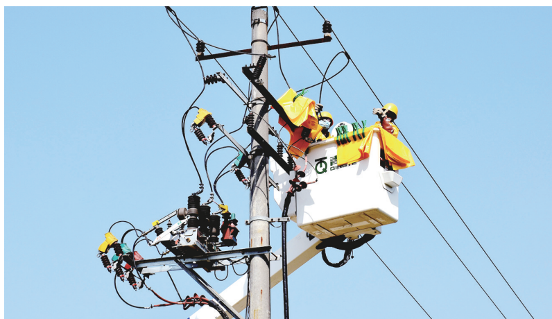
3月24日,供电职工正在进行“不停电作业”。为切实做好线上教学保供电工作,连日来,国网怀宁县供电公司涉及各类通讯基站、网络运营公司机房等重点设施、场所的供电线路开展专项巡视行动,确保网络设备正常、信号传输通畅。
