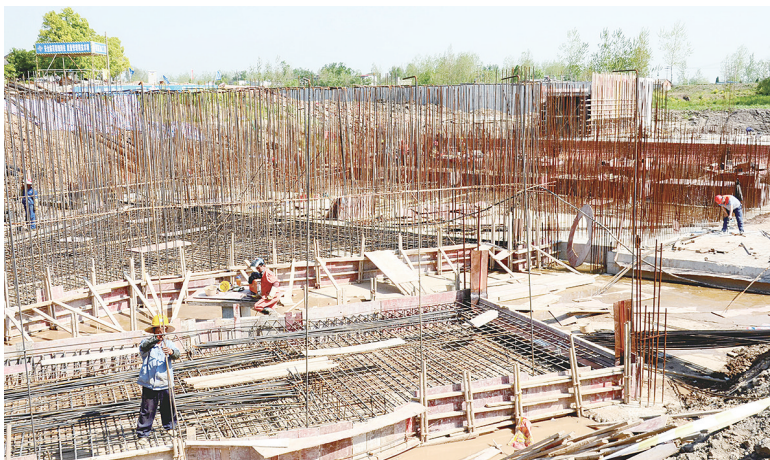
4月14日,大观区广成圩北闸工程建设工地,工人正在轧制压力涵箱。目前,已完成堤身砼护坡、泵室水泵层砼浇筑、翼墙4米高度砼浇筑等工程。将于4月20日完成洪闸门落闸。 项顺平 记者 黄有安 摄
