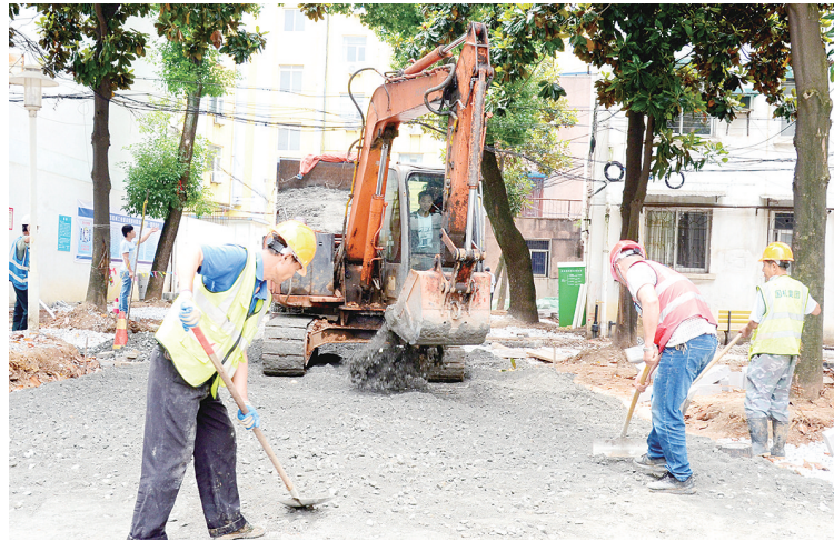
5月21日,大观区正在四方城社区进行老旧小区改造项目建设施工。此改造工程为2020年安庆市大观区海绵街区建设PPP项目,共投资约1.4亿元,预计年底完成改造任务。记者 黄有安 通讯员 项顺平 摄
