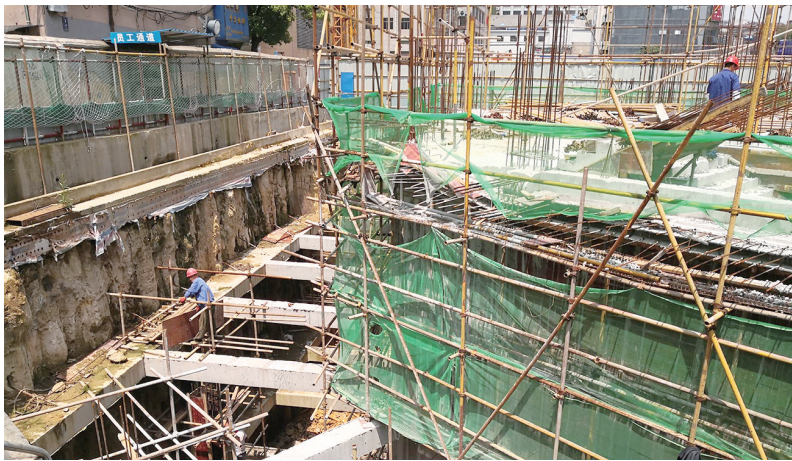
5月26日，建设路某在建工地正在施工作业。
