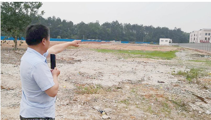
图为施工中的驾校
