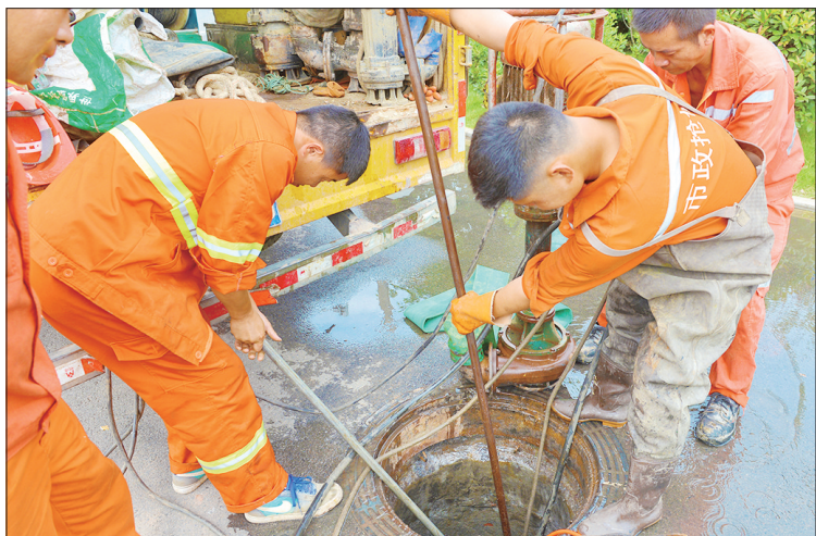
6月9日上午，在科技路和创业路交叉口处，市政工作人员正在进行排涝作业。进入雨季，市政部门积极开展道路积水点整治工作，加大力度开展积水点排查整治工作。目前已整治了龙眠山路、集贤北路、顺安路、皖江大道、集贤南路等道路共9处积水点。
