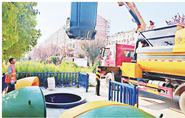
吊装式压缩运输车在收运深埋式垃圾桶内垃圾。 汪少华 摄
