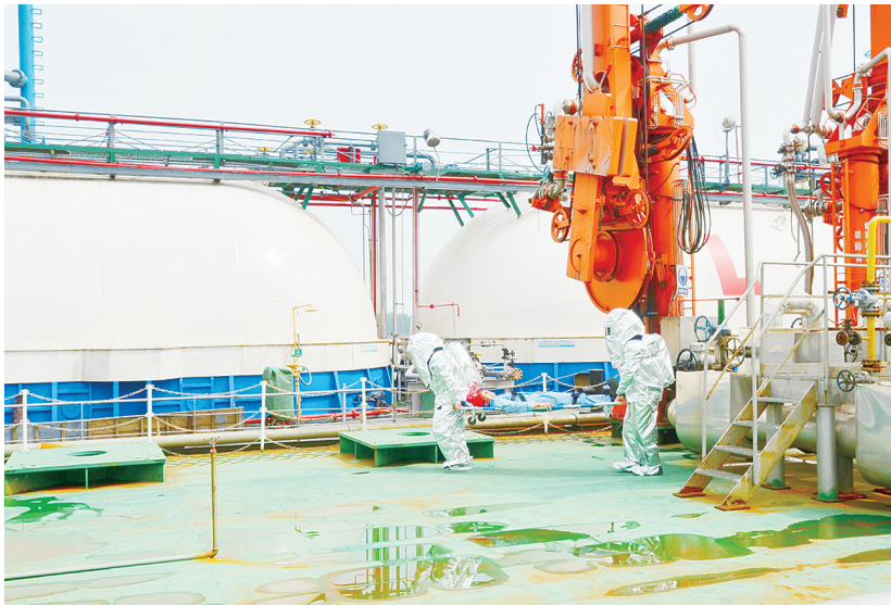
6月19日下午,安庆石化危化品码头举行1号趸船接卸臂泄漏事故演练。
