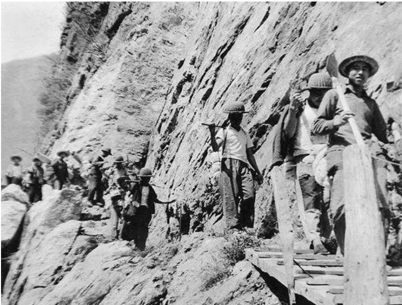
当年,建筑者们在横断山脉的悬崖边修建成昆铁路。(作者供图)
