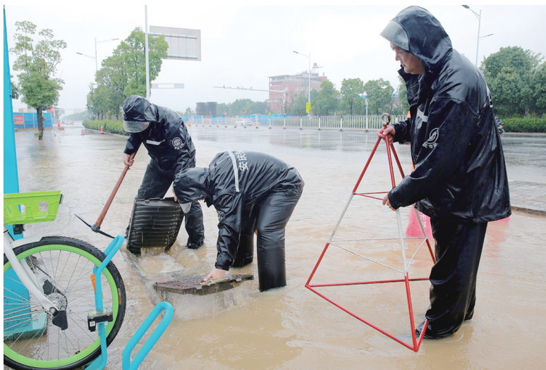
7月5日上午,在宜秀区中山大道,市政工程管理处抢险队员正在排除内涝积水。当日凌晨,我市出现强降雨天气,造成城内部分地段积水,市政部门第一时间赶赴排除内涝,确保道路畅通。 记者 江胜 摄
