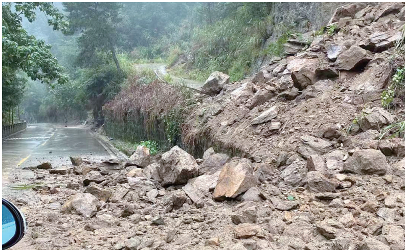
岳西县菖蒲镇主干道发生山体滑坡。 李海滨 摄
