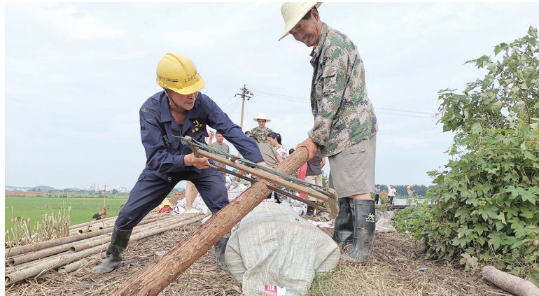
大团结圩杨桥镇段堤顶上,镇村两级干部、区水利技术专家及村民们正在全力以赴除险保圩。 记者 沈永亮 摄
