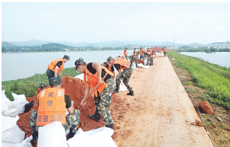
7月14日下午2点,在怀宁县洪铺镇东西圩堤上,千余名武警官兵和镇村干部正在加固堤防。 记者 程扬 通讯员 郑超 摄
