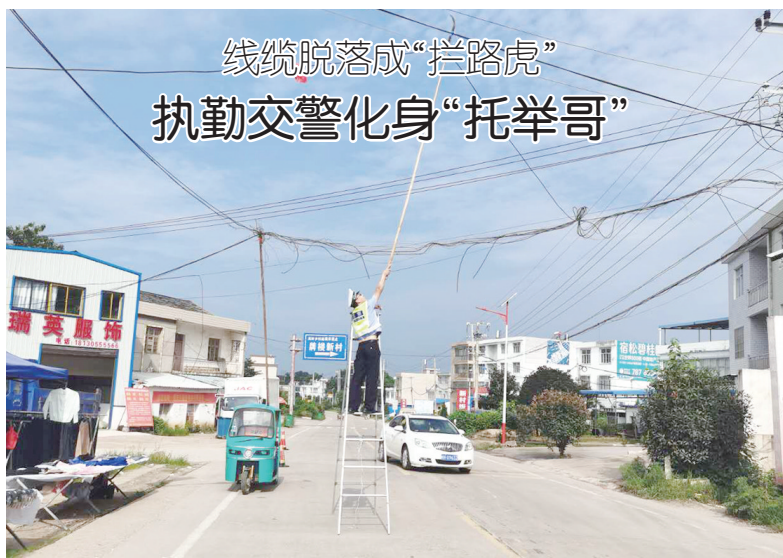
交警罗良伟站在人字梯上托举线缆。
