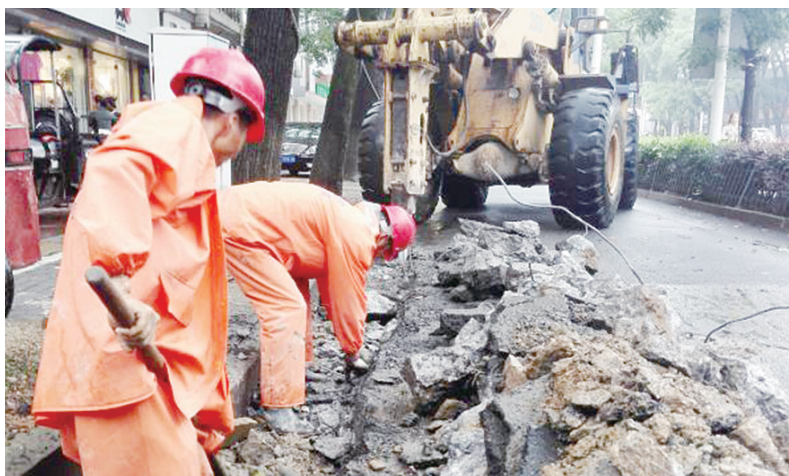
在集贤南路与黄土坑路交叉口一处积水点,施工人员正在冒雨抢修排水管道。 记者 罗少坤 摄
