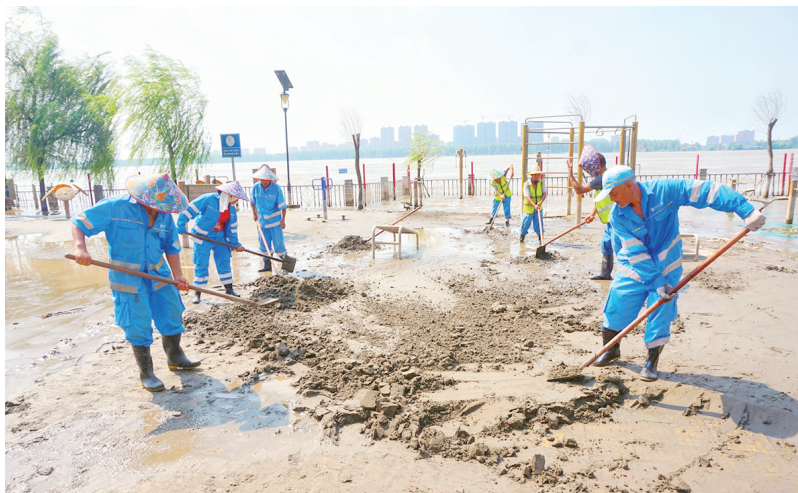
8月2日,在我市安广江堤29号闸口内的观景平台上,10多名环卫工人正在对江泥进行清理。
