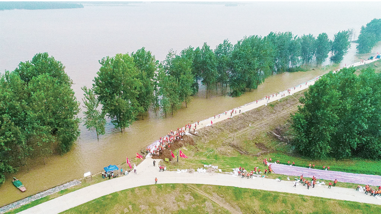
7月15日下午,在望江县雷池乡巩固圩上,71集团军某旅官兵正在加固防浪堤。记者 路欣 通讯员 方明 摄
