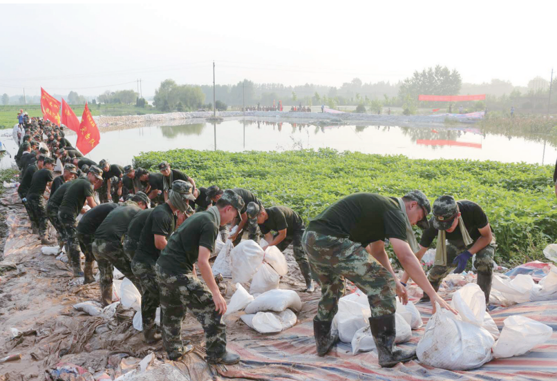
7月16日上午,迎江区新洲乡永乐圩管涌灾害现场,武警安庆支队战士正在全力加固子堤。 通讯员 金字航 摄
