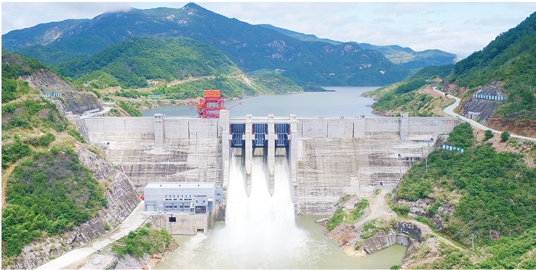
下浒山水库工程3个闸门全部打开,腾空库容,为迎战洪峰做好准备。(7月3日 汪云峰 摄)
