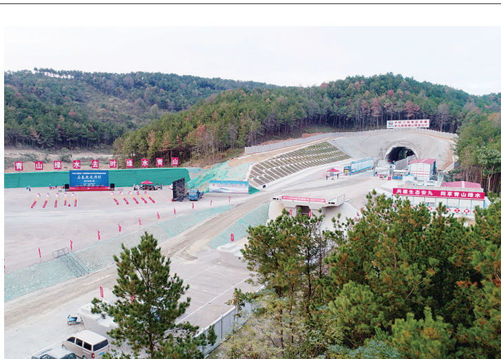
8月14日上午11时20分,中铁三局安九三标项目部施工的安九铁路安庆段横山隧道顺利贯通。横山隧道地处宿松县河塌乡兴岭村与长铺镇铁寨村之间,全长805米,是安九铁路安徽段正线上唯一的一座隧道。该隧道的贯通标志着安九铁路安徽段正线主体工程的全面拉通,为下一步全面推进无砟轨道施工和2021年底全线建成通车奠定了基础。
