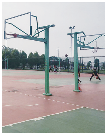
篮球架上篮板缺失。
