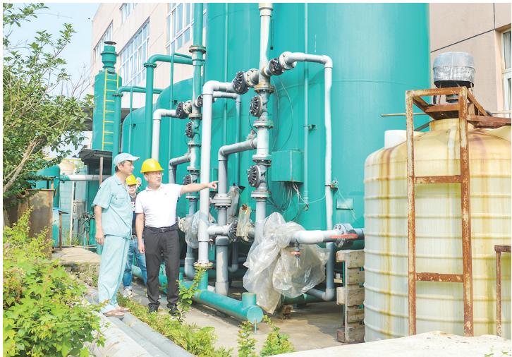
8月26日,工作人员正在宜秀区经济开发区一企业钠离子分离罐区进行安全检查。
